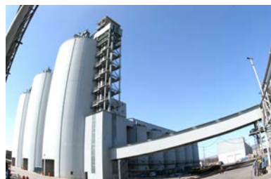
▲ 高炉矿渣超细粉生产线
