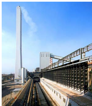
▲ 焦炉煤气脱硫脱氰
