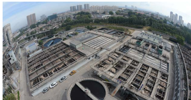
▲ 工业废水处理
