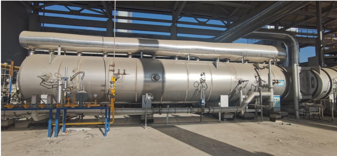
图 4-4 DFTO 焚烧炉设施图片
