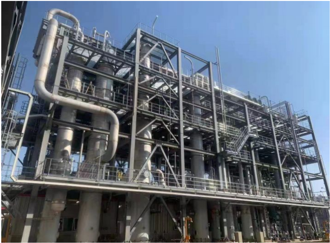
图 4-2 2 级洗涤塔设施图片
