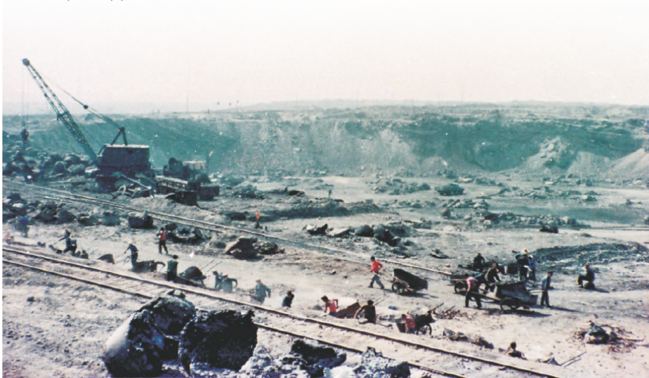
热火朝天的治渣现场
