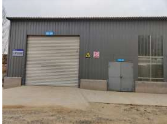
危废暂存间标识
