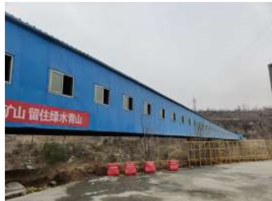
全封闭运输走廊
