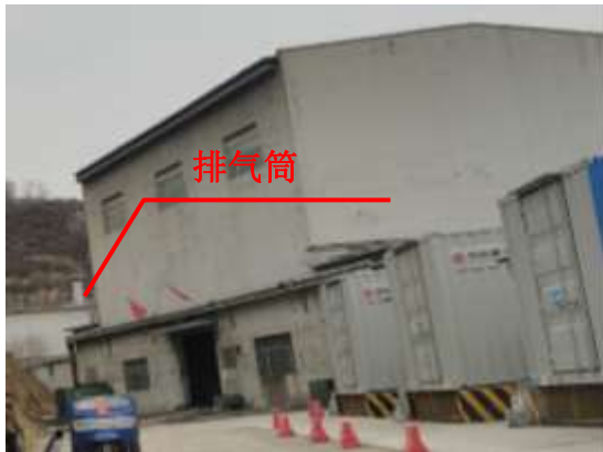
主厂房及排气筒
