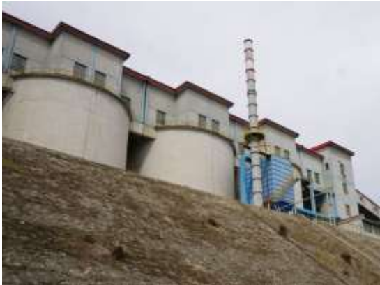
中贮仓除尘器及排气筒
