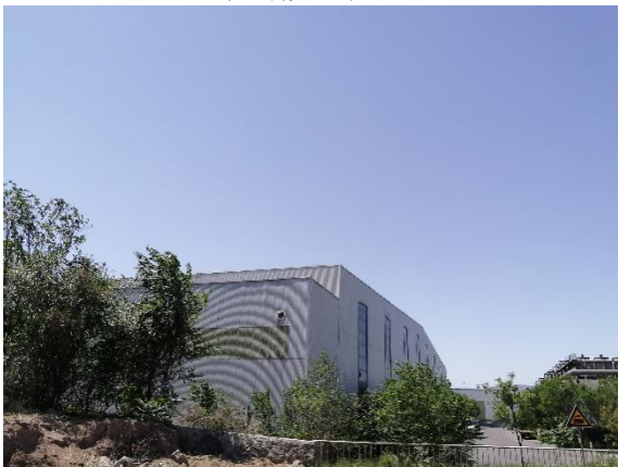
(5) 拟建项目场地西侧 ——太钢硅钢冷连轧车间
