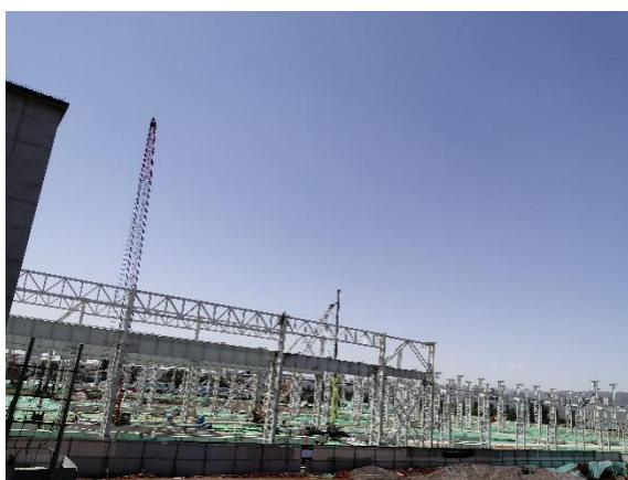
(4) 拟建项目场地南侧 ——建设中的取向硅钢工地
