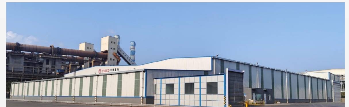
山东太钢鑫海不锈钢有限公司炼钢厂合金料库扩容封闭改造项目
