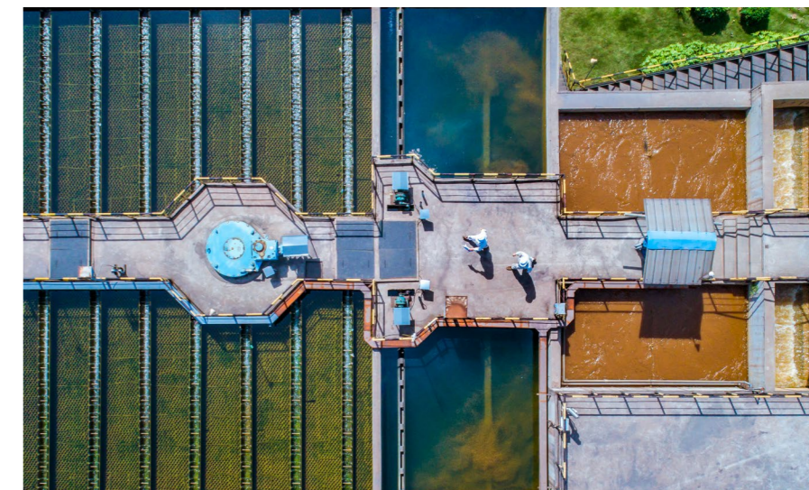
● 马钢集团六分河污水处理系统 Magang Group Liufenhe Wastewater Treatment System
