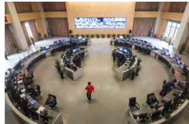
▲ 全球首套大型炼铁控制中心实现了对四座高炉的集中化操作控制和生产管理。
