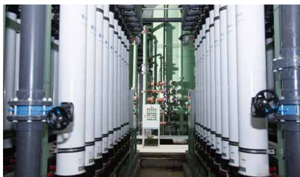
鄂城钢铁焦化酚氰废水处理站除盐系统
