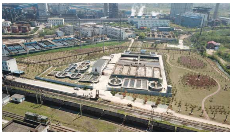
酚氰废水改造项目
