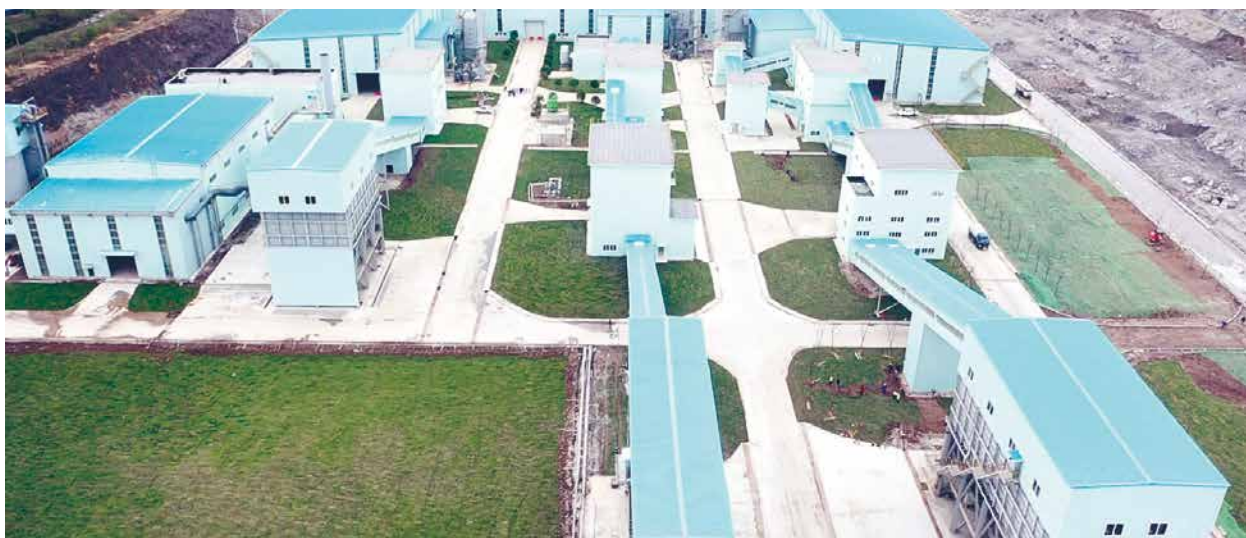
武钢金资钢渣二次加工中心项目
